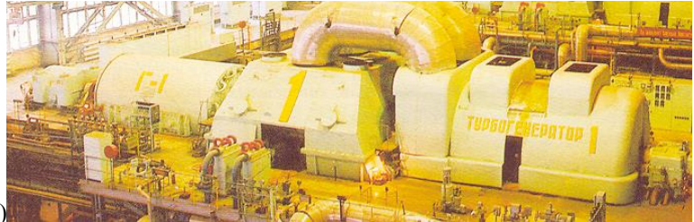
Рисунок 2.35. а) - Фото машинного зала ГЭС с синхронными генераторами; б) - Фото машинного зала ТЭС с одним энергоблоком с синхронным генератором и паровой турбиной
